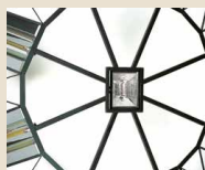
Éclairage central (ECC)
